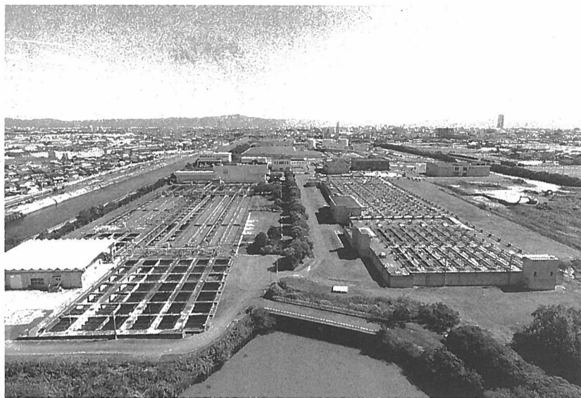
豊橋市が管理している処理場で最も大きな中島処理場
